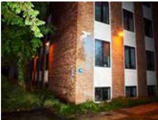
Sachbeschädigungen am Dienstgebäude des Senators für Inneres
